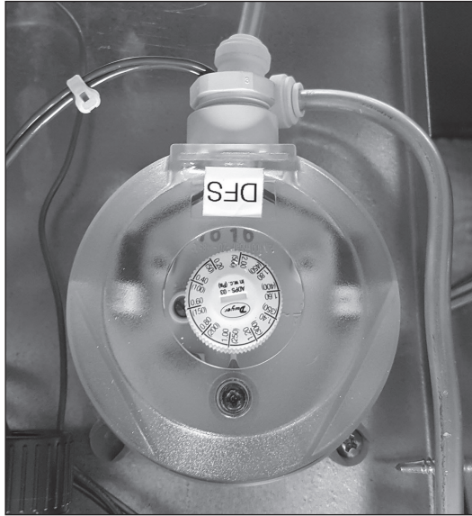
Figure 26.3 – Pressostat « filtre sale »
